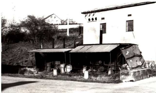
Le transformateur électrique et devant le bouilleur de cru qui s'installait tous les ans.
