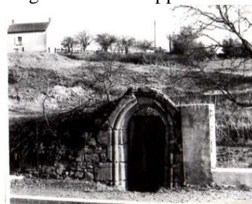
Porte de la chapelle du Saint-Esprit
