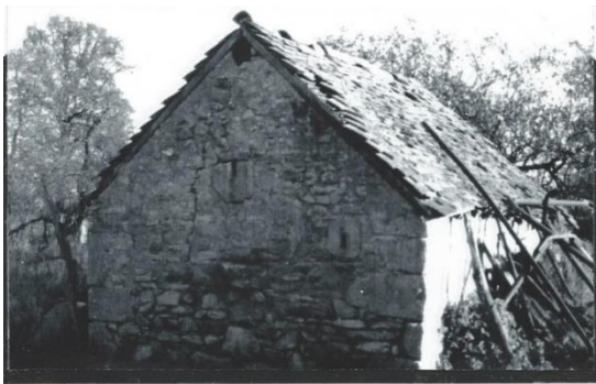
Curieux bâtiment à La Loge
