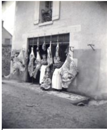
Boucherie Gautier rue de la caserne
